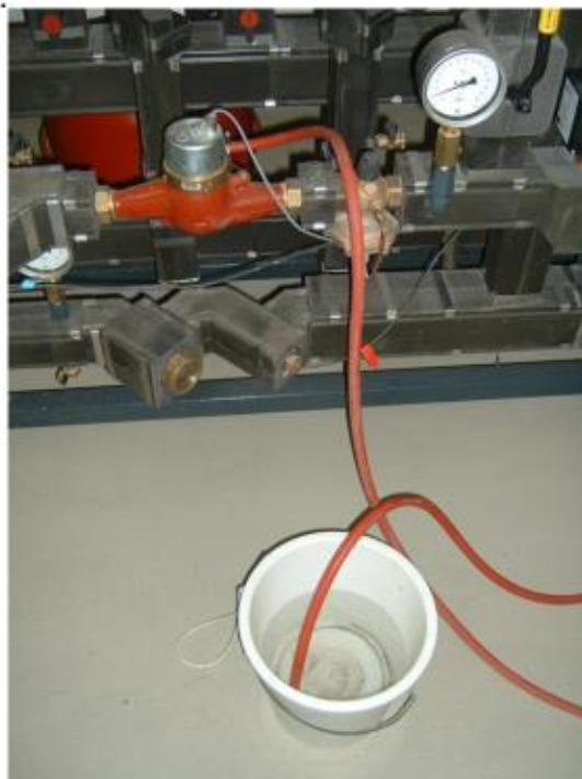
Ci-dessous : prélèvement d'échantillons d'eau de chauffage. Cette dernière est propre et claire.
