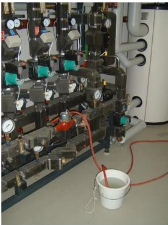
Ci-dessous : prélèvement d'échantillons d'eau de chauffage. Cette dernière est propre et claire.
